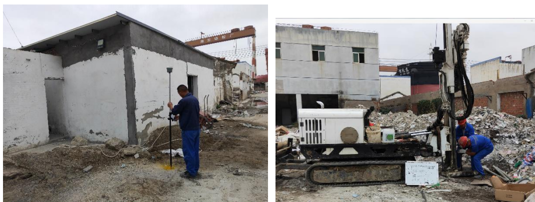
图 4.4-3 Geoprobe 钻探系统现场钻探
